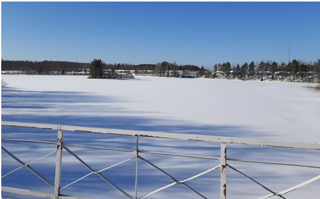
Rautatien penger ja silta talvimaaisemassa. Näkymä Siltatien sillalta kohti rautatietä.
